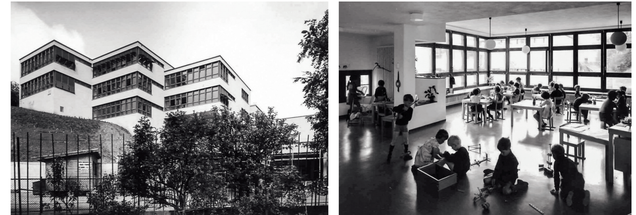
Primarschulhaus Riethüsli in St. Gallen, 1964–1967. Architekten Oskar Müller und Mario Facincani, St. Gallen. Unbekannter Fotograf, Archiv des Hochbauamts Stadt St. Gallen.
